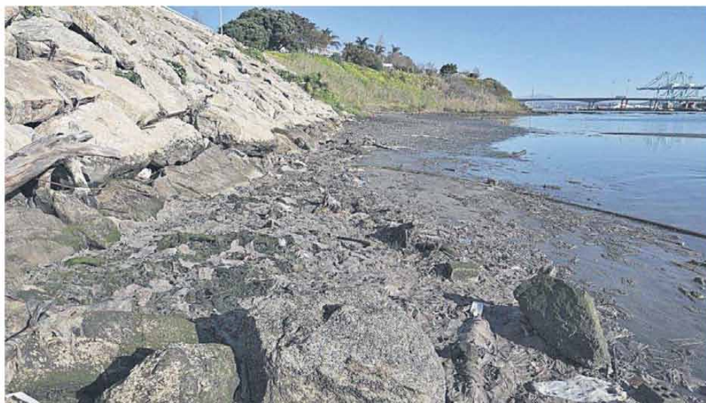
La salida de la EBAR de Los Ladrillos.
