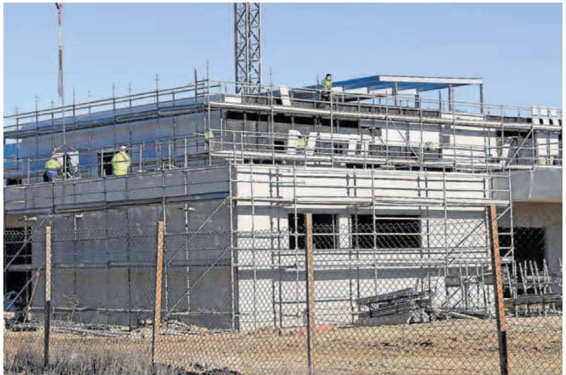
Obreros trabajan en la actualidad en la construcción del centro de salud de Nueva Segovia, una de las actuaciones promovidas por el Junta. A. TANARRO
