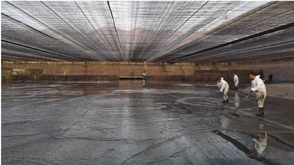
Imagen de las labores de limpieza de la balsa de decantación
