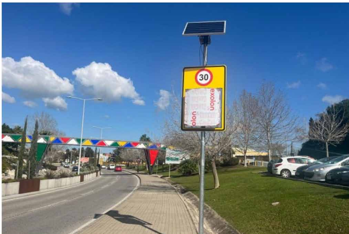
Nuevo radar instalado en Algeciras, junto al colegio Mediterráneo. / Noelia García Cortés
